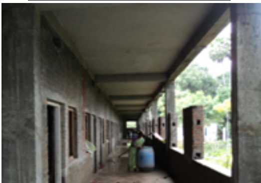
ベランダ(廊下)の壁塗りも始まりました。
