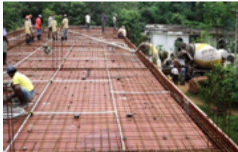
屋上にセメントを流しています。
