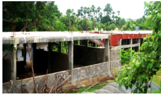
柱が建ち、屋根が上がりました。
